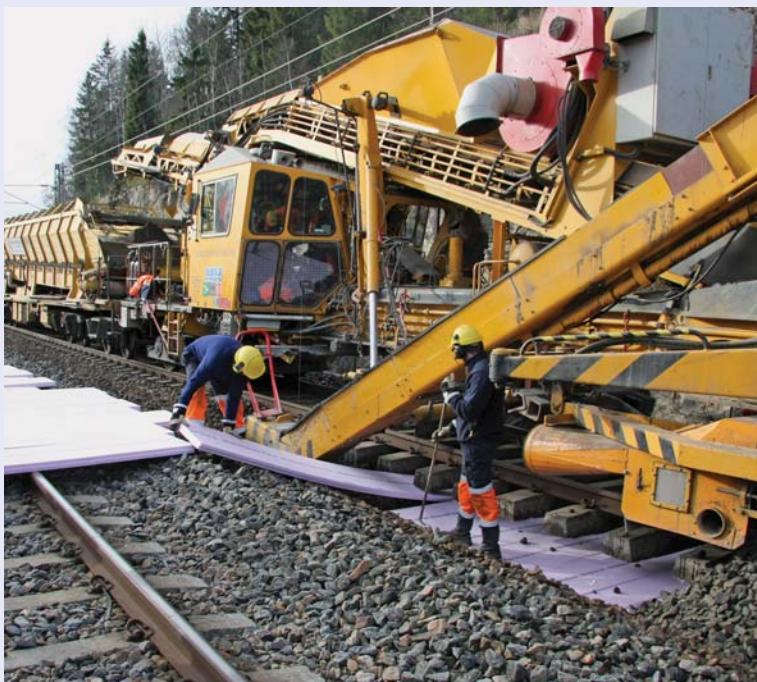
Tjälisolering av järnväg.
