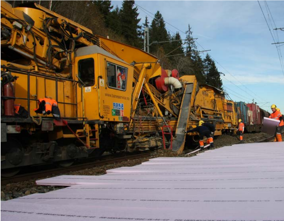
Isolerlåda skyddar mot frost och tjälskjutning.
